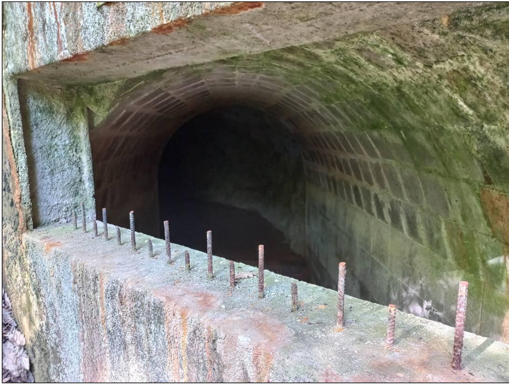
13) kép: Az Antal-táró speciális lezárása a mesterséges üreget szálláshelyül, szaporodóhelyül, illetve telelőhelyül használó denevérek védelmét szolgálja (Recsk 42/A)
