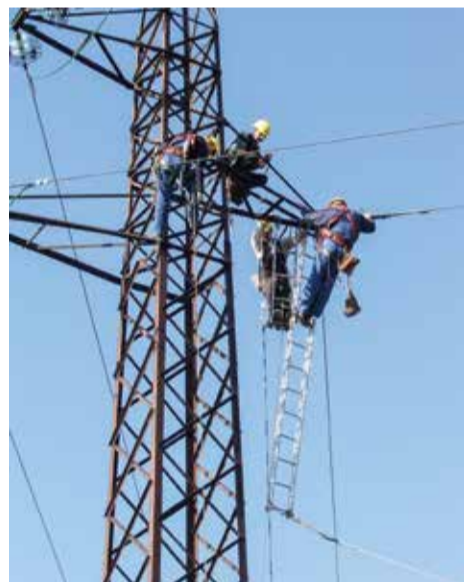
Feszítőoszlop szerelése (Fotó: BNPI archívum)
