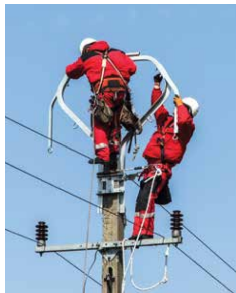
Oszlopfej szerkezet szerelése (Fotó: BNPI archívum)
