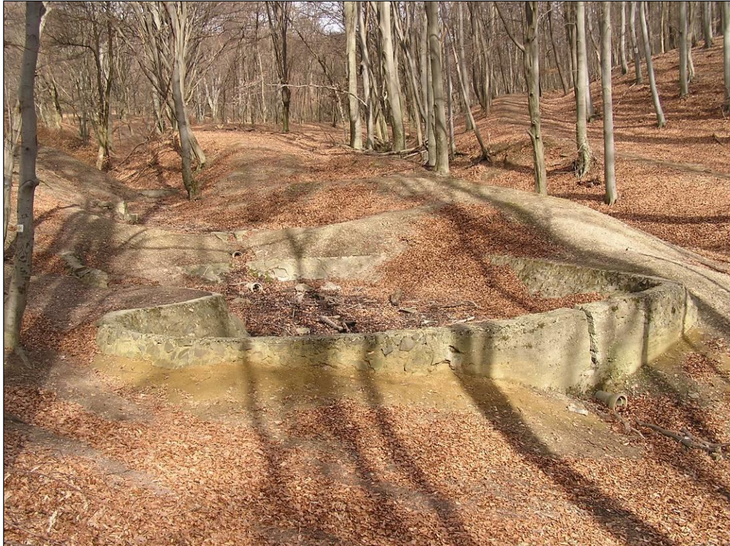
7) kép: Régi, elrepedt gáttestű vízgyűjtő medence a Gyopár-forrás alatti völgyszakaszon, idős gyertyános állomány alatt (Salgótarján 116/D; KE-1)
