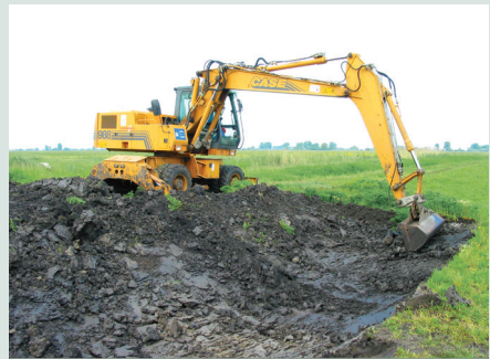
Épül az élőhely-rekonstrukciót szolgáló gát (B. P.)
